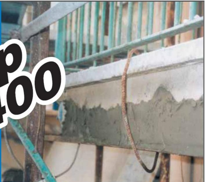
**Быстросхватывающийся тиксотропный раствор с контролируемой усадкой для ремонта поверхностей из железобетона (толщина нанесения 1-40 мм).**
